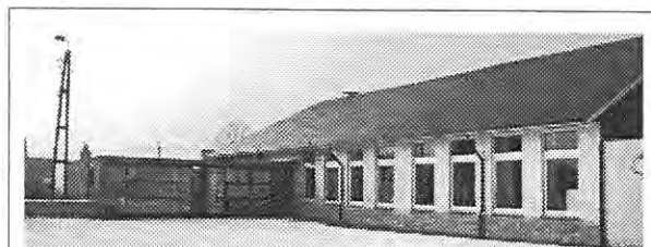
La nouvelle école a été bâtie sur les fondations de l'ancienne...
