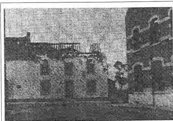
Au carrefour de Quinaux, l'artillerie a causé des dégâts aux maisons.
