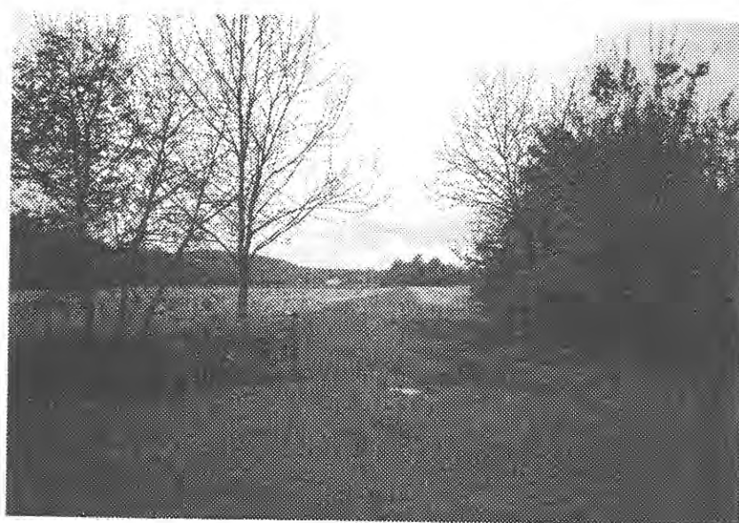
Les traces du chemin empierré qui conduisait au gisement sont encore bien visibles. À l'avant-plan, le ponceau qui a remplacé le gué sur le Crespon.
