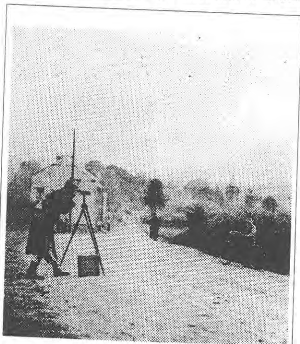
Repérage au théodolite pour les tirs d'artillerie. On devine la tour de l'église de Wierde à l'arrière-plan.
