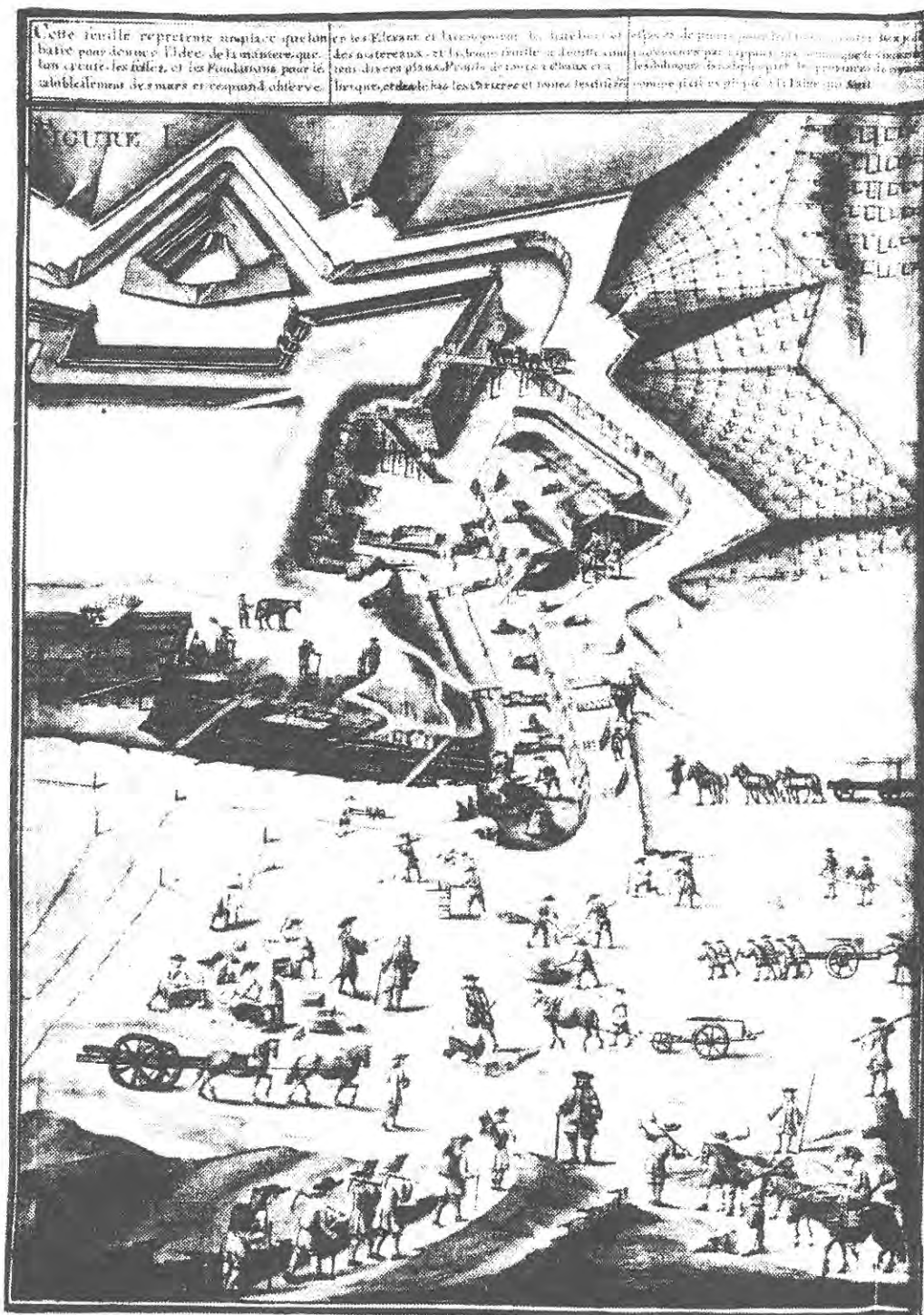
La construction d'une place forte d'après une planche de l'Atlas de Masse, un collaborateur de Vauban.
