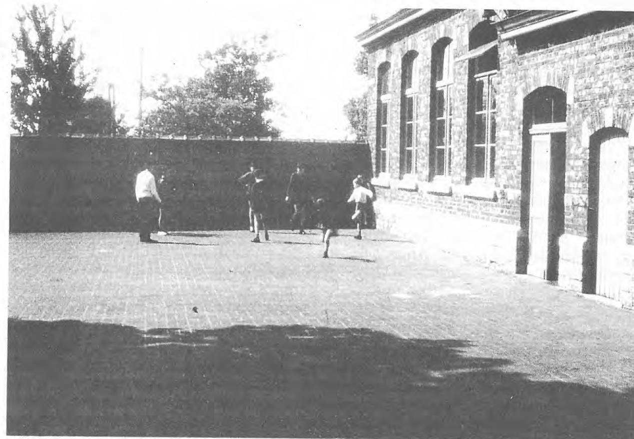
Vue de l'école depuis l'ombre d'un tilleul
