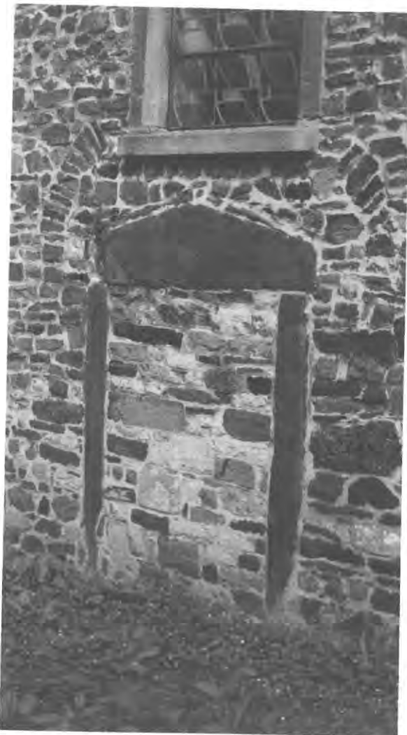
Porte septentrionale, dite « des manants », murée actuellement.
