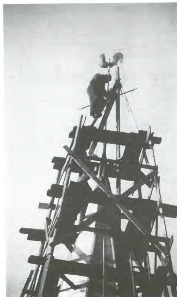
Restauration du clocher dans les années 60.
