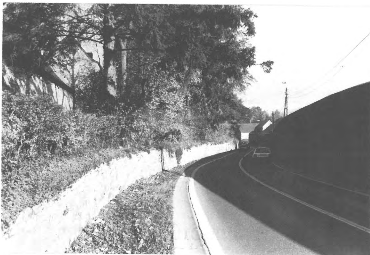
Les murs de clôture de la rue de Jausse.
