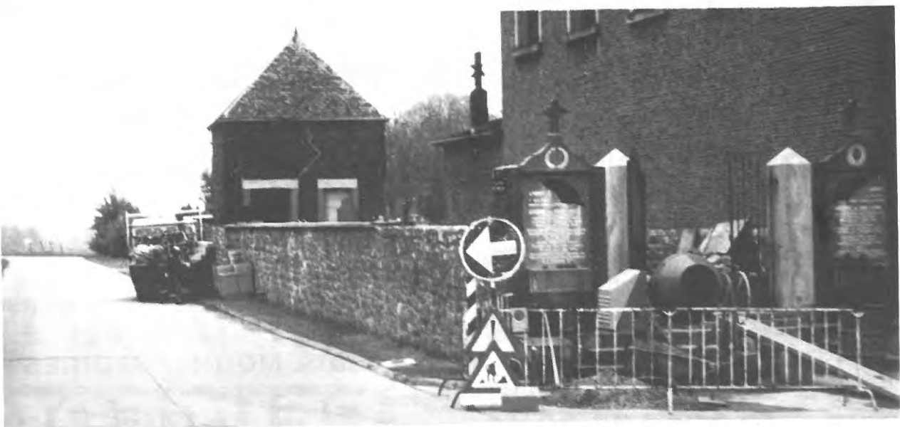
Restauration du mur du cimetièr d'Andoy. Un beau travail de la Ville. Merci.
