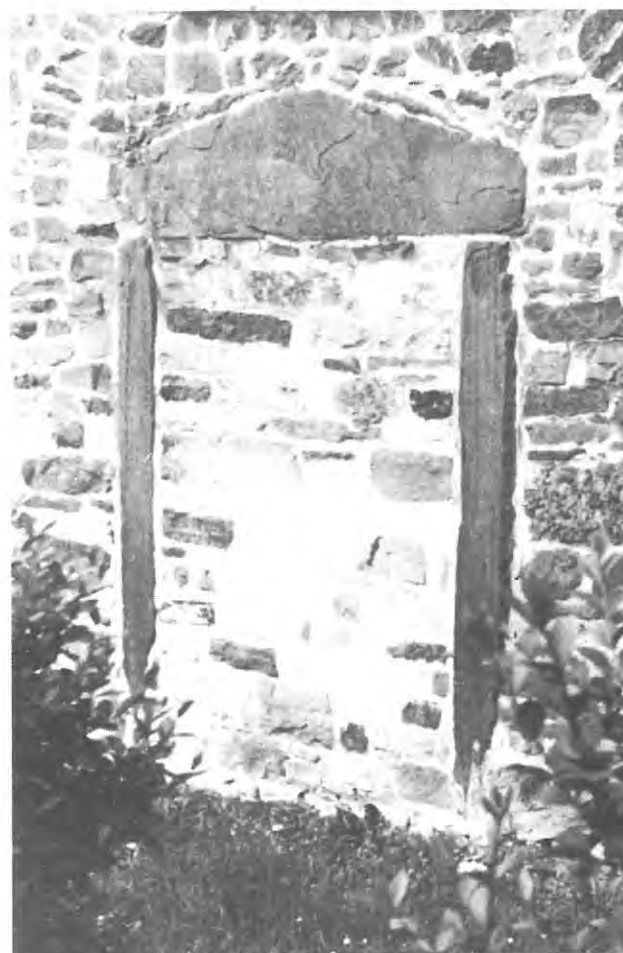
La petite porte ou "porte des manants" de l'église de Wierde.
